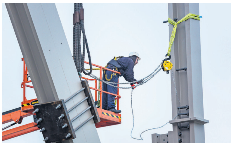
Monteurs fixeren het spant vanuit hoogwerkers.
